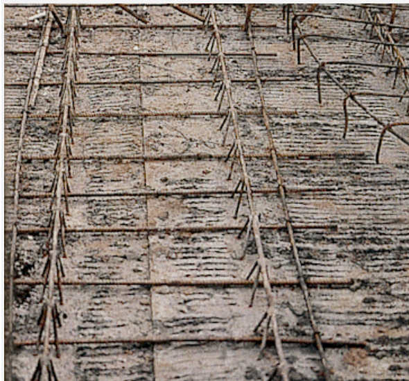
Styki płyt zbroi się siatką lub prętami średnicy 6-8 mm.
