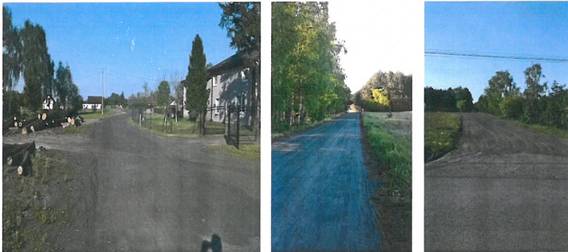
Zdjęcie 1. Przykładowe drogi w Klamrach wymagające modernizacji
