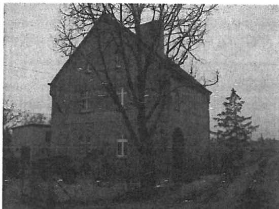
Zdjęcie 2. Świetlica wiejska w Klamrach
