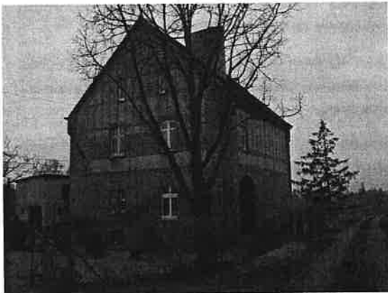
Zdjęcie 2. Świetlica wiejska w Klamrach
