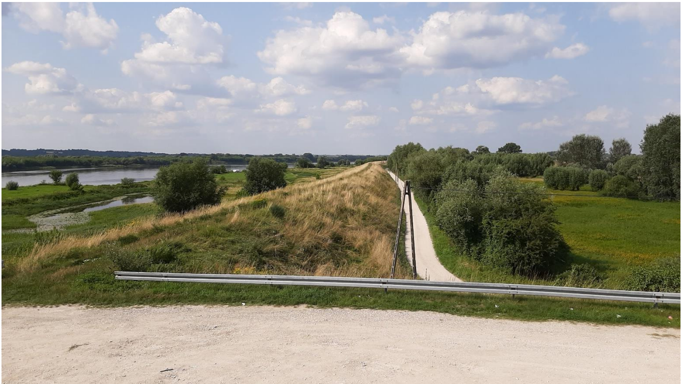
Fot. 1 Międzywale i zawale z wieży widokowej w Borównie (widok w kierunku północnym)
