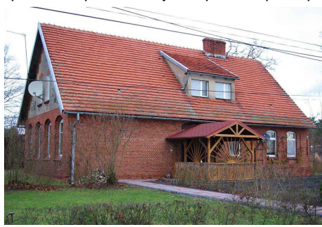
Ryc. 26. Budynek dawnej szkoły w Górnych Wymiary.
