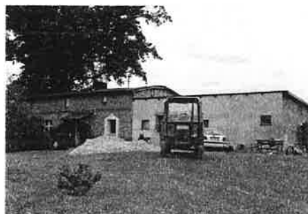
Ryc. 41. Dom z budynkiem gospodarczym z 1900 r.
