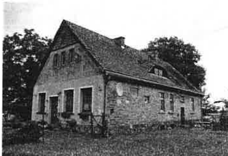
Ryc. 40. Dawny budynek szkoły z ok. 1913 r.
