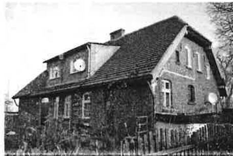
Ryc. 36. Dawny budynek szkoły z ok. 1913 r.
