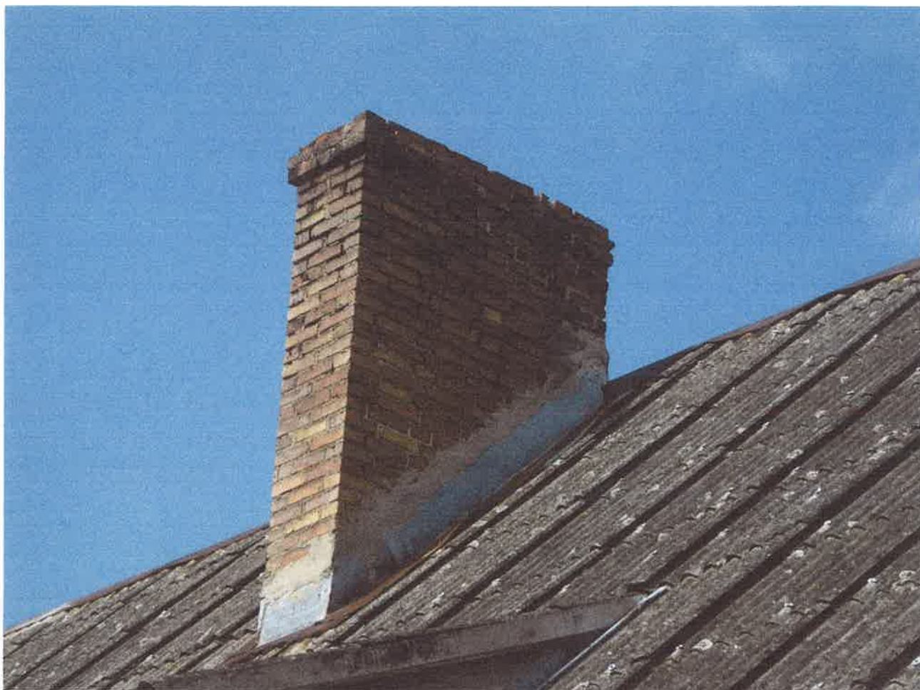
Fot.6. Stan zachowania kominów – ubytki spoin
