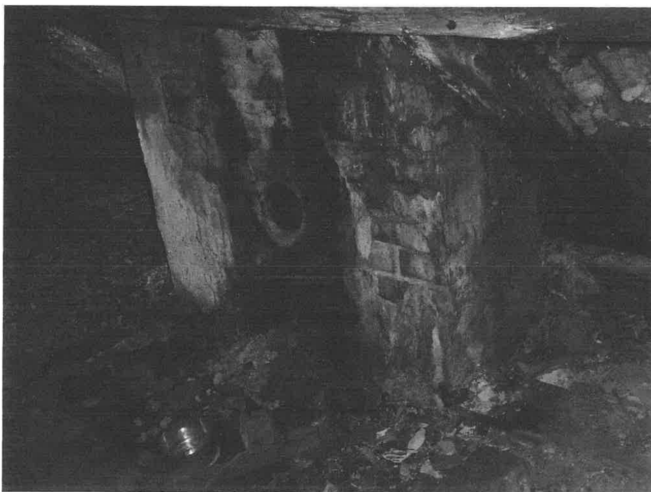
Fot.9. Zawilgocone i porażone białą pleśnią krokwie i wymian – nieszczelność przy kominie
