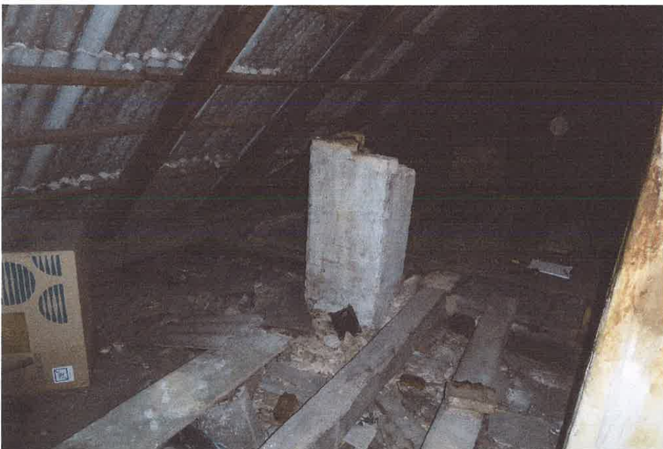
Fot.7. Rozebrany komin pod połacią
