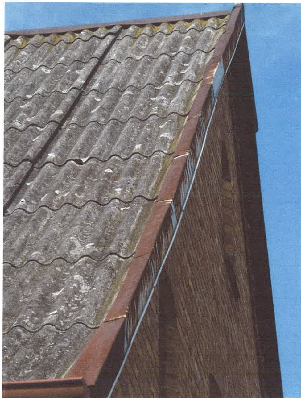
Fot.5. Stan zachowania opierzeń ze stali ocynkowanej
