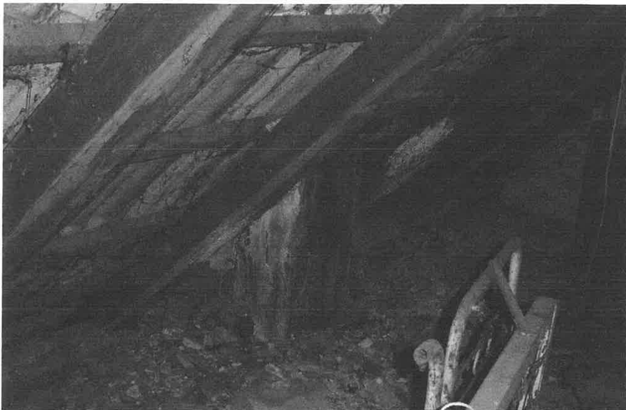
Fot.8. Zawilgocone i porażone białą pleśnią krokwie – nieszczelność przy kominie
